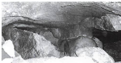
39 白神岩屋A天井部分
