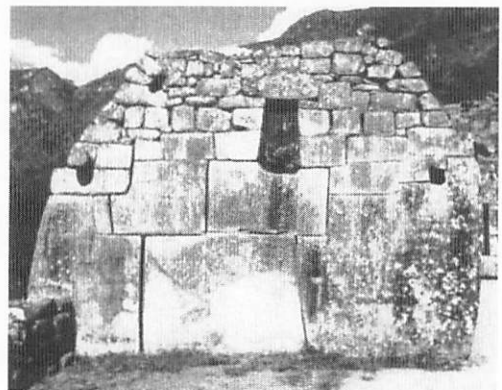
Fig.2 インカの石組み一剃刀の刃も通らぬ
